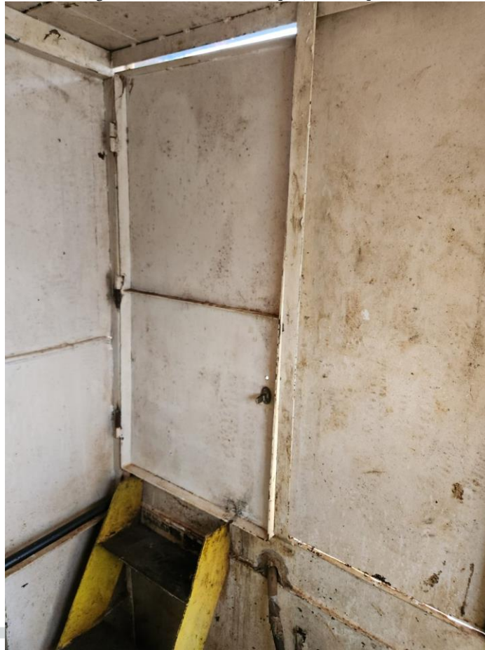
Figura 8 – Porta de acesso a praça de máquinas.
