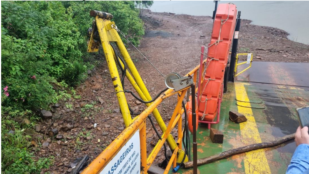
Figura 18 - Guincho de atracação dos rebocadores.
