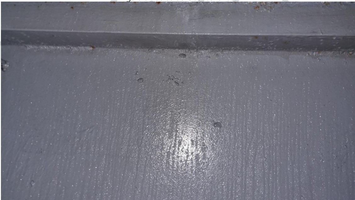
Figura 6 - Solda deve ser contínua.
