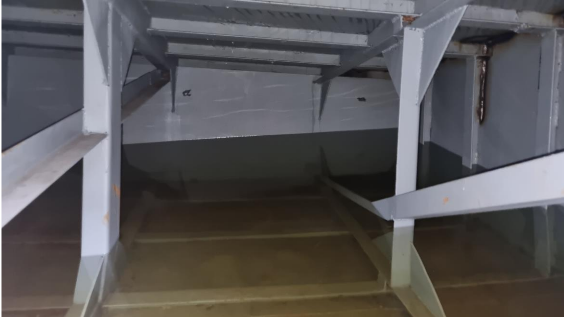
Figura 15 - Compartimentos alagados.
