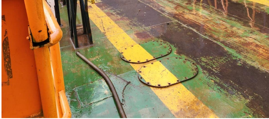
Figura 1 – Escotilhas de acesso ao fundo
