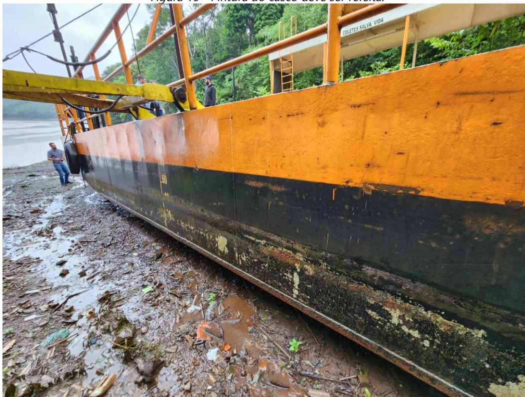
Figura 16 - Pintura do casco deve ser refeita.
