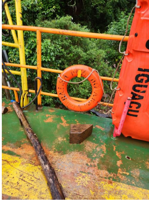
Figura 24 - Boia de salvatagem, deve ser substituída.
