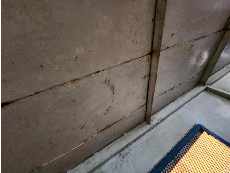
Figura 2 - Teto da praça de máquinas.
