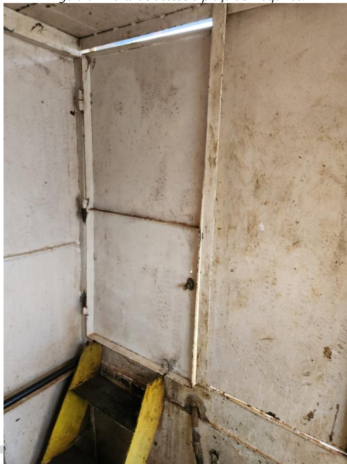
Figura 8 – Porta de acesso a praça de máquinas.
