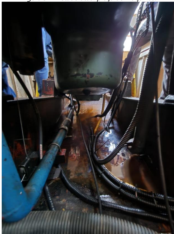
Figura 31 – Estado atual praça de máquinas.
