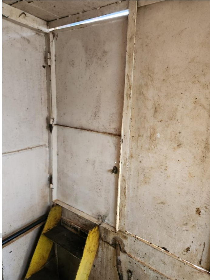
Figura 10 – Porta de acesso a praça de máquinas.
