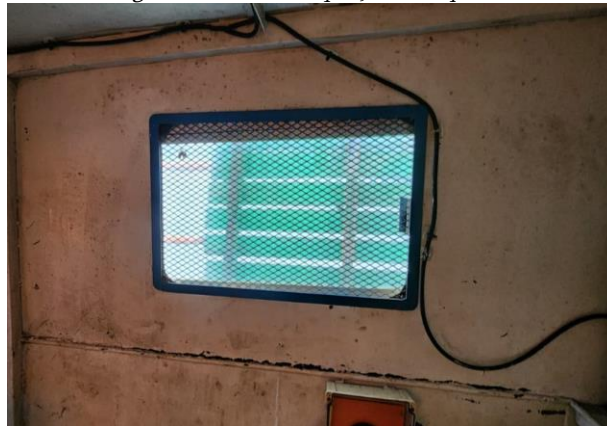
Figura 12 – Vidro da praça de máquinas
