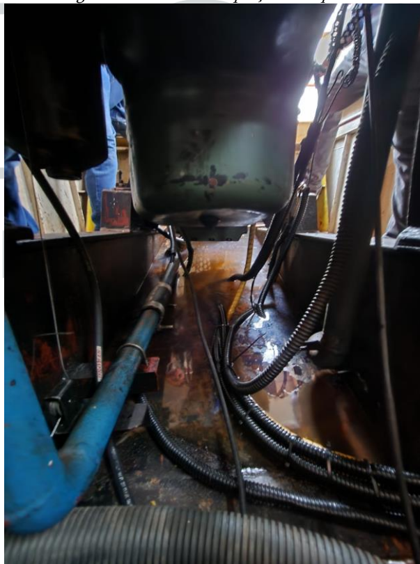
Figura 34 – Estado atual praça de máquinas.
