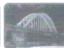
Ponte do Arco
