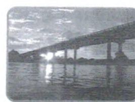
Ponte Domicio Scaramella
