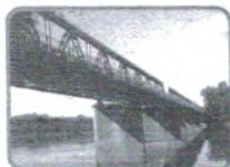
Ponte Machado da Costa (Ponte de Ferro)
