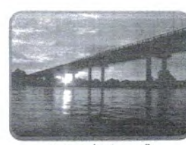
Ponte Domicio Scaramella
