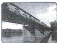
Ponte Machado da Costa (Ponte de Ferro)
