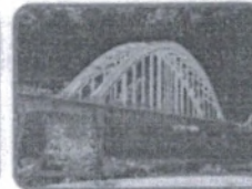
Ponte do Arco
