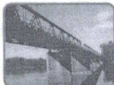
Ponte Machado da Costa (Ponte de Ferro)
