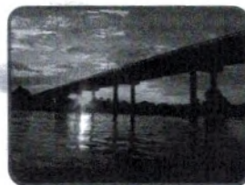
Ponte Domício Scaramella
