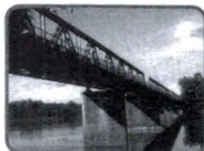
Ponte Machado da Costa (Ponte de Ferro)
