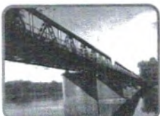
Ponte Machado da Costa (Ponte de Ferro)
